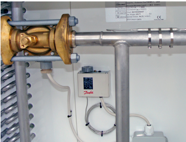
1'000 kg/Std. atmosphärischer ASCO CO 2 -Verdampfer Thermostat
