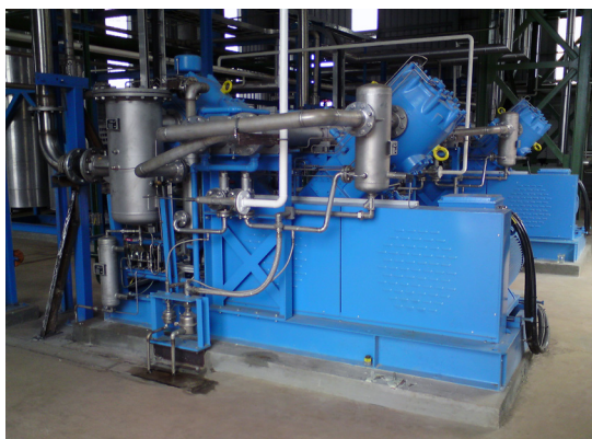
Zweistufiger CO 2 -Verdichter
