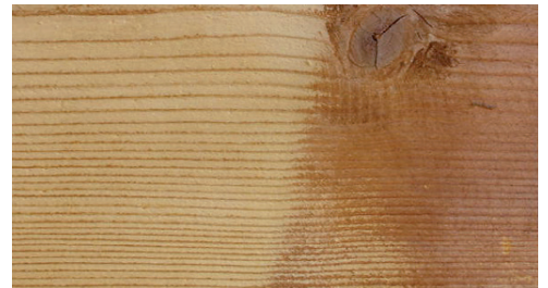
Holzfassade vor und nach der Reinigung
